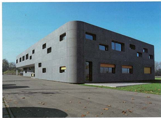
La sede della società Phg di Augsburg, in Baviera, una delle aziende specializzate appartenenti a Longogroup.
